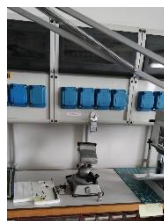
Ambientale 8 Lato corridoio
