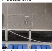
Ambientale 4 Lato corridoio
