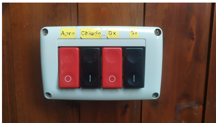
Figura 6. Sulla parete a sinistra dell'ingresso sono presenti 4 pulsanti rossi/neri per la sua movimentazione.
