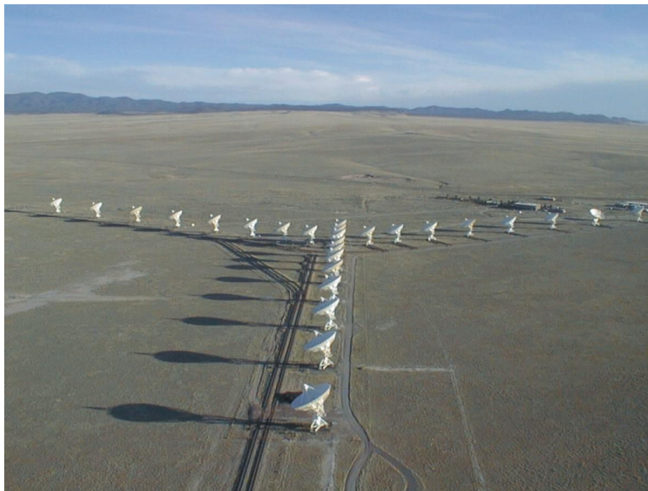
Figura 28 Very Large Array , un sistema per la ricezione delle onde radio astronomiche costituito da 27 antenne paraboliche, situato in New Mexico 18 .
