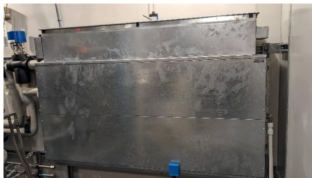
Figura 12 Termoconvettore vertex room
